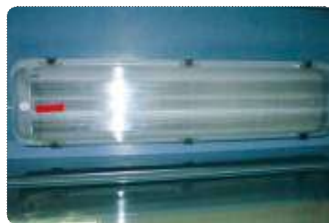
ВЗРЫВОЗАЩИЩЕННЫЙ СВЕТИЛЬНИК EEX NA II CT5
